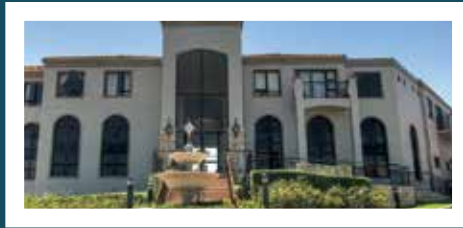
VILLA CORTONA, DURBANVILLE
